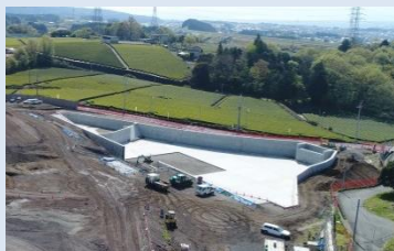
雨水調整池の様子
