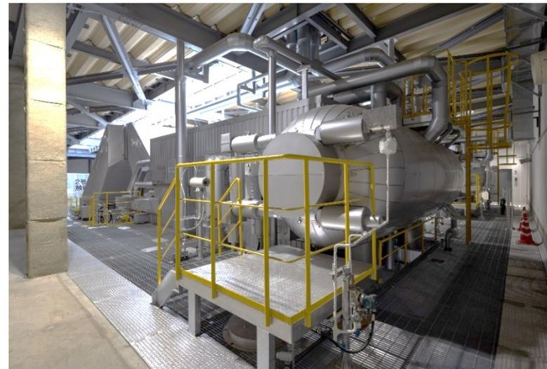
ボイラは焼却炉と一体になっています。内部にはたくさんの水管が設置されています。高温の排ガスが通ることで、水管のなかの水は蒸気になります。
