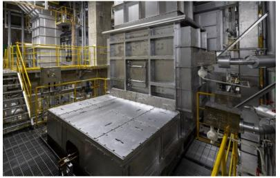
とうにゅう しょうきゃくろ とうにゅう きゅう ごみ投入ホッパから焼却炉に投入されたごみは、給じん そうち すこ しょうきゃくないぶ おく 装置で、少しずつ焼却炉内部に送られていきます。
